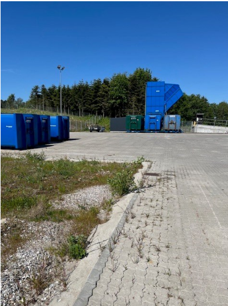
Komprimatoranlæg og ekstra containere til udskifning. Set fra øst.
